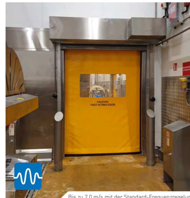
Bis zu 2,0 m/s mit der Standard-Frequenzregelung
